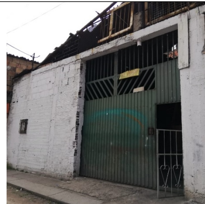
FOTOGRAFÍA No.2 FACHADA PREDIO
