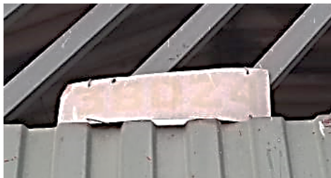
FOTOGRAFÍA No.1 NOMENCLATURA PREDIO
